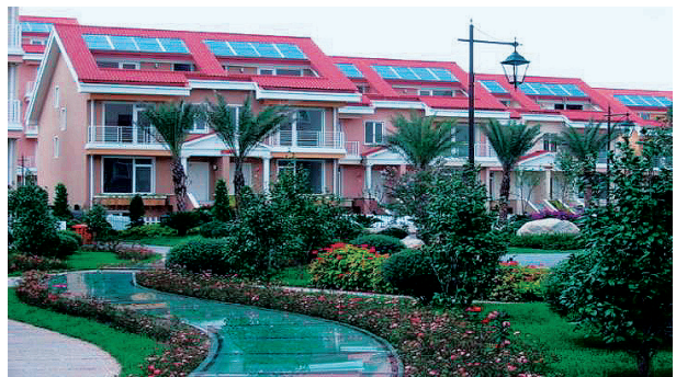
图 4.3 云南昆明与建筑结合的太阳能热水系统
